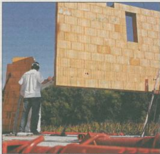
Fertigwand statt vor Ort mauern
